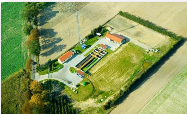
Fot. 13. Oczyszczalnia ścieków w Pruszczu.
