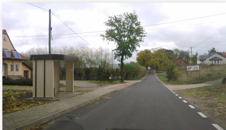
Fot. 9. Przebudowana w 2014r. droga powiatowa nr 1282C w Parlinie
