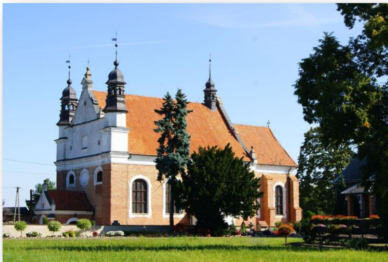
Fot.3. Kościół parafialny pw. Nawiedzenia NMP w Topolnie.
